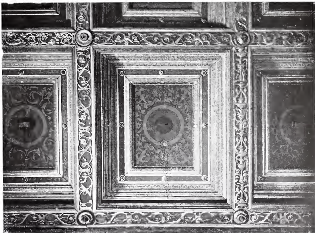
PARTICOLARE DI SOFFITTO IN LEGNO CON PITTURE E TARSIE.
