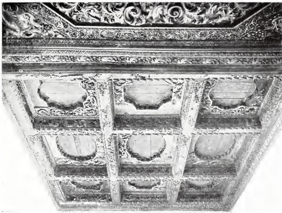
CASTELLO — SOFFITTO DI LEGNO INTAGLIATO DEL CINQUECENTO.
