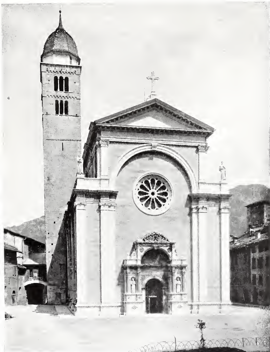
CHIESA DI SANTA MARIA MAGGIORE. FACCIATA RIMODERNATA E PASSAGGIO SEGRETO CHE METTE ALLE CASE DI VIA LARGA.
