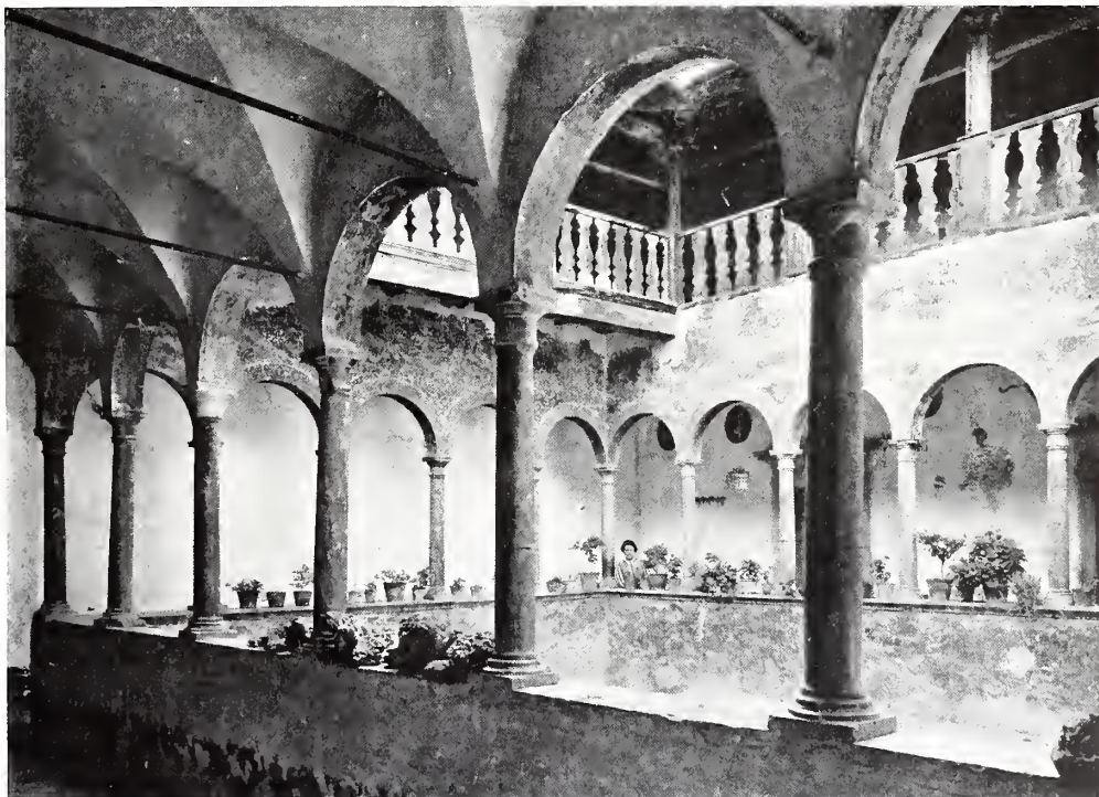
CASTEL TOBLINO — LA LOGGIA INTERNA.
