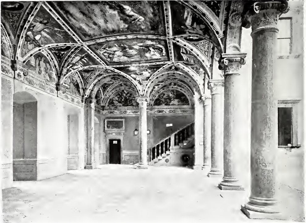
CORTILE DEI LEONI — INTERNO DELLA LOGGIA.
