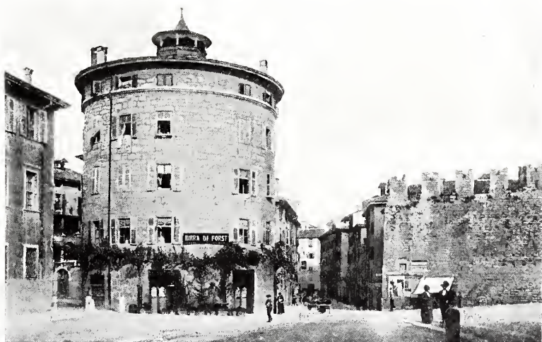
BORGO NUOVO — LE MURA DETTE DI TEODORICO E IL TORRIONE DEL 1580.
