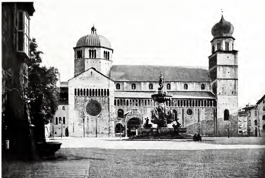
IL DUOMO PRIMA DEL RIFACIMENTO DELLA CUPOLA E DEL TETTO.
